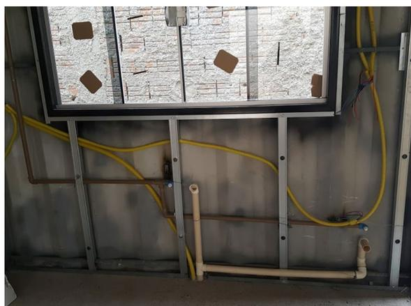
**Figura 3:** Instalações elétricas e hidrossanitárias - **Fonte:** Up! Container, 2018
